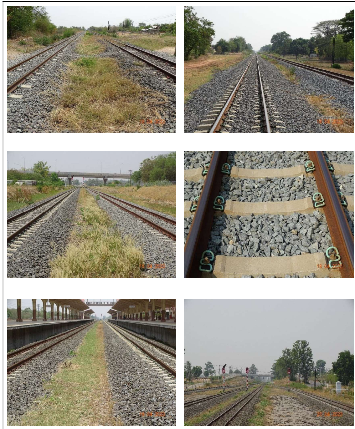
รูปที่ 2.2-4 พืชคลุมดินและการโรยหินกรวดเพื่อป้องกันการชะล้างพังทลายตลอดแนวทางรถไฟ
