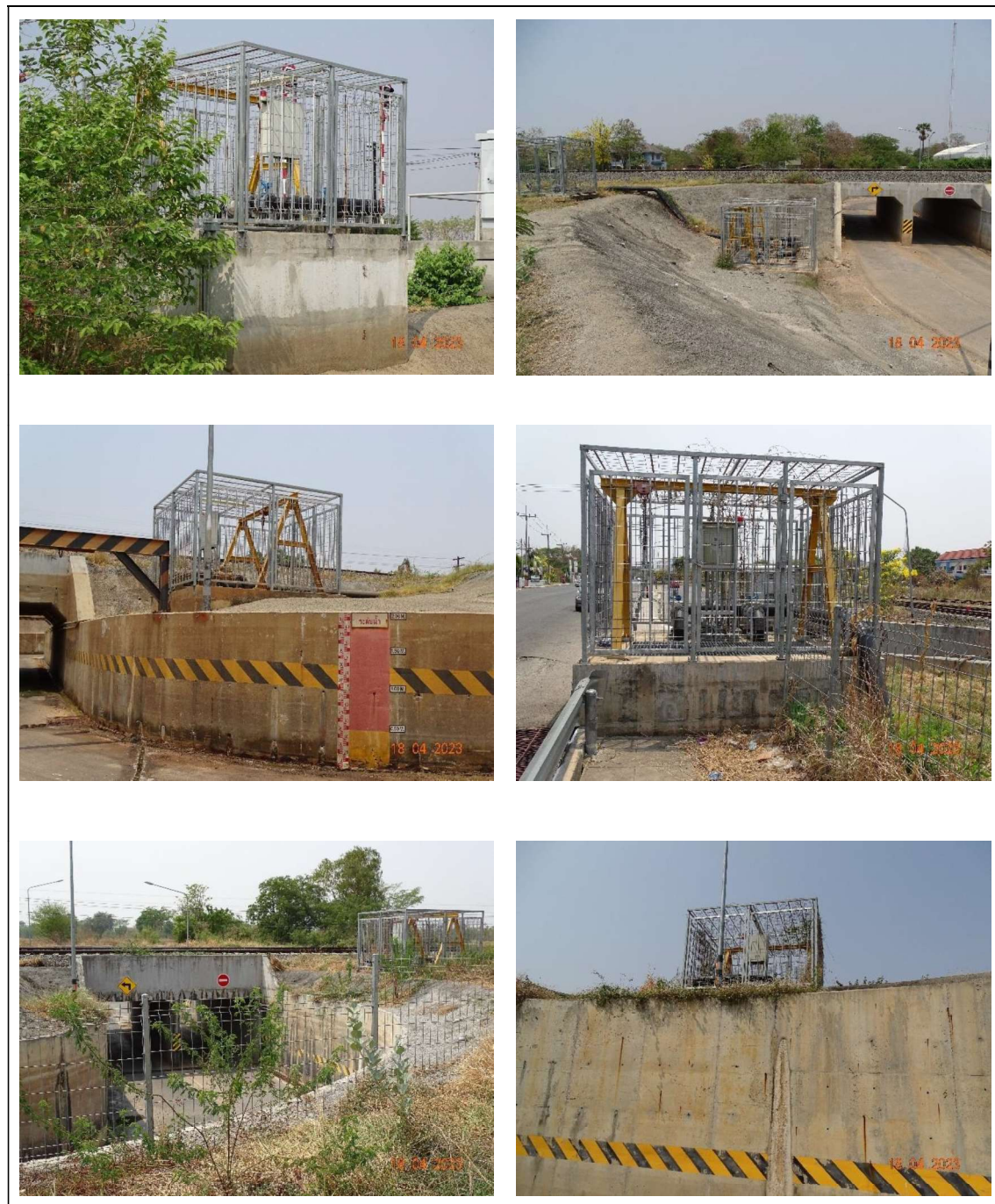
รูปที่ 2.2-18 บั้มสูบน้ำอัตโนมัติในบริเวณที่เป็นทางลอด
